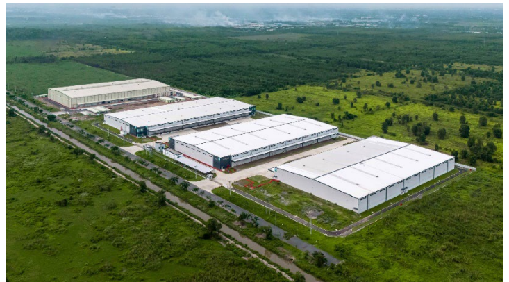
Hình 16: Dự án NKXS tại Khu công nghiệp Lê Minh Xuân 03 (tp.HCM)
